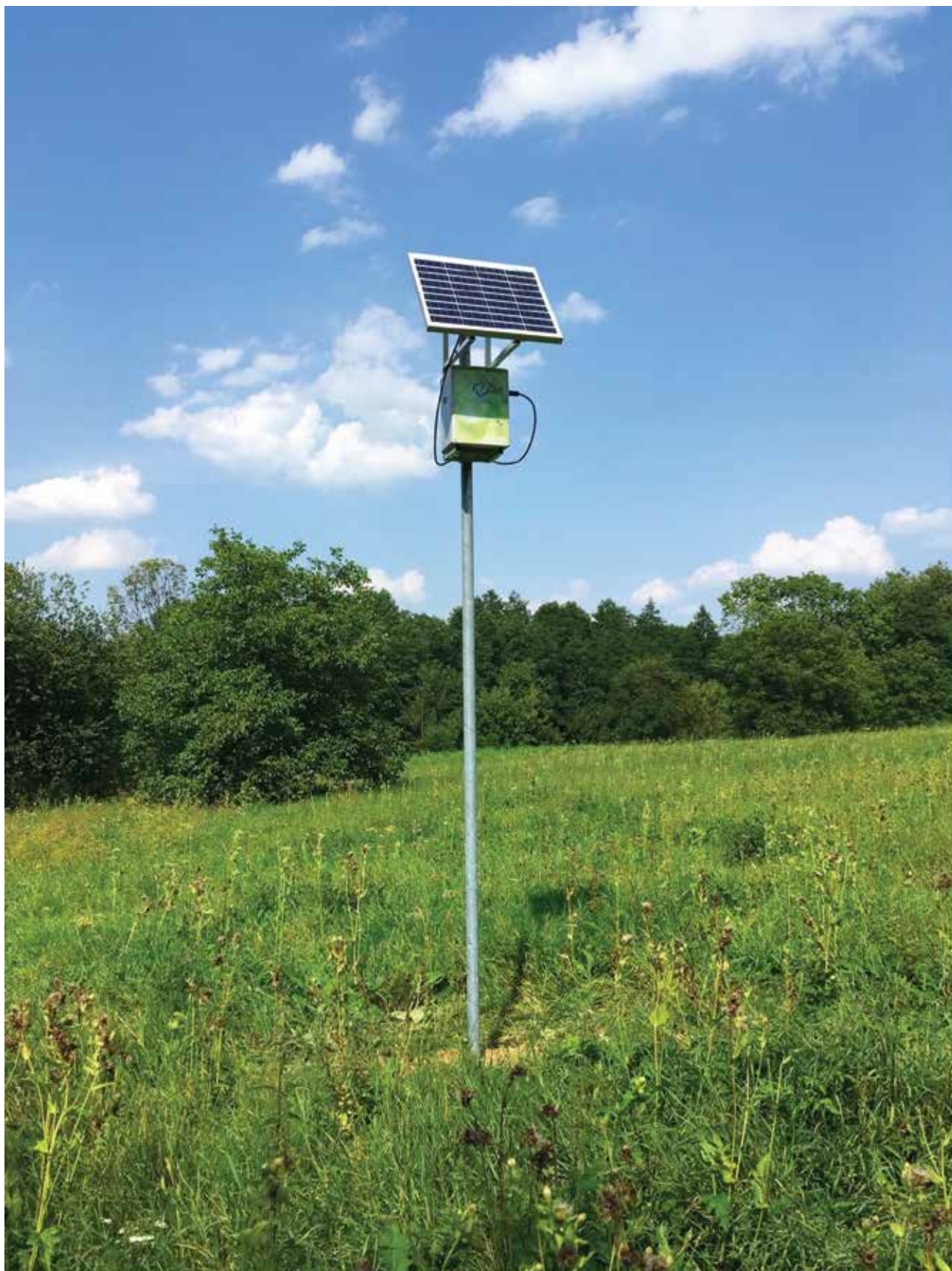
Rys. 11.1. Zdjęcie przedstawiające typową instalację w lokalizacji Radwanice.
