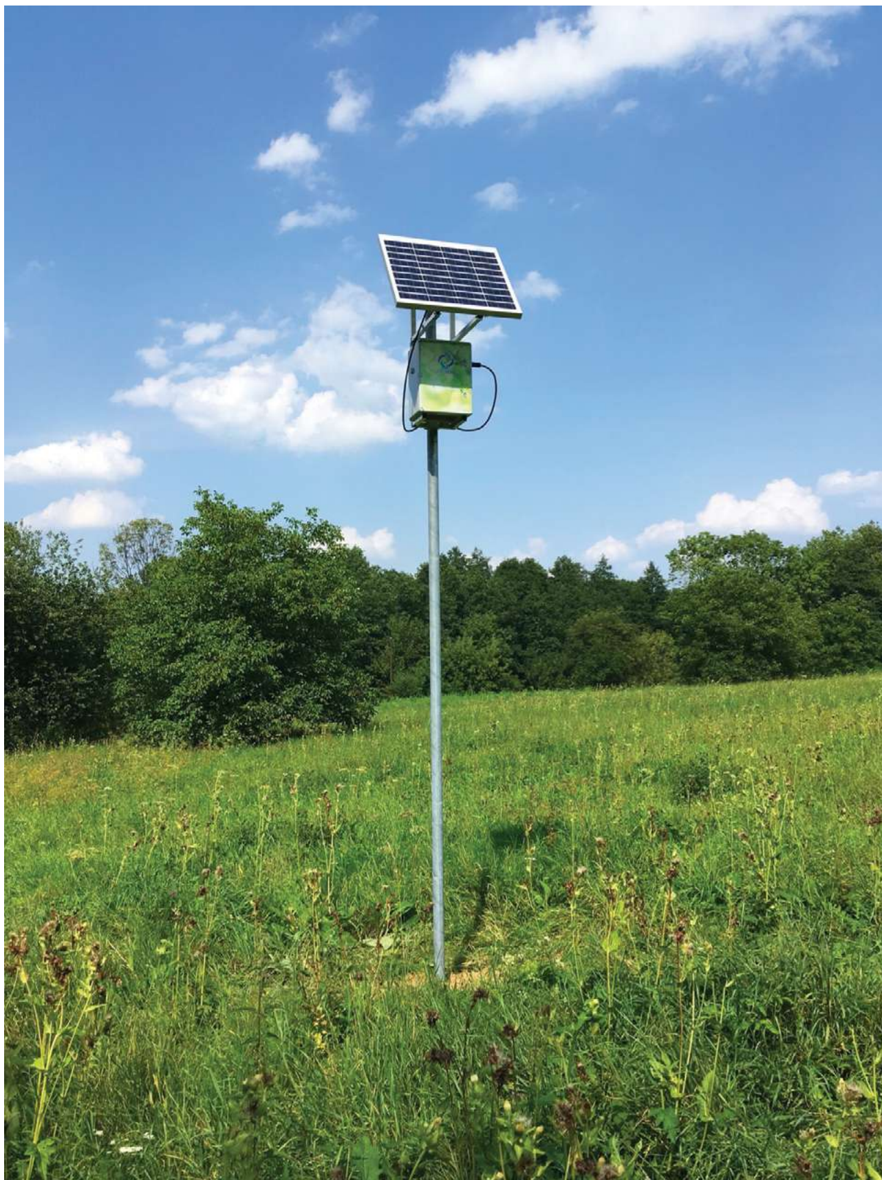
Obr. 11.1. Fotografie typické instalace v lokalitě Radvanice.
